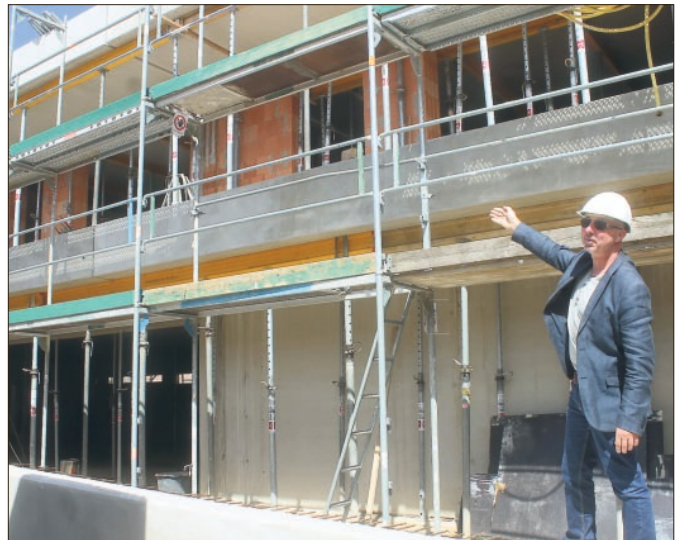
Noch nicht ganz so weit: Der hintere Bereich an der Königsberger Straße ist komplexer, dort ist das erste Obergeschoss soweit fertig, erklärt Architekt Ronald Wascher. ■ Fotos: Ehlers
