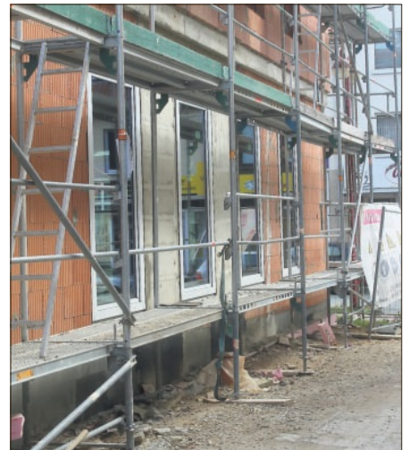
Um wieder Zeit zu gewinnen, sind bereits Fenster eingesetzt worden, obwohl das Dachgeschoss erst noch in Angriff genommen wird, hier das Erdgeschoss.
