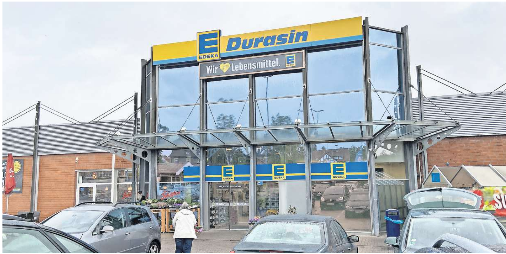
Der Elzer Edeka soll vom Saaledamm in die Innenstadt umziehen. Das sorgt für Reibereien mit dem Denkmalschutz des Landkreises.
