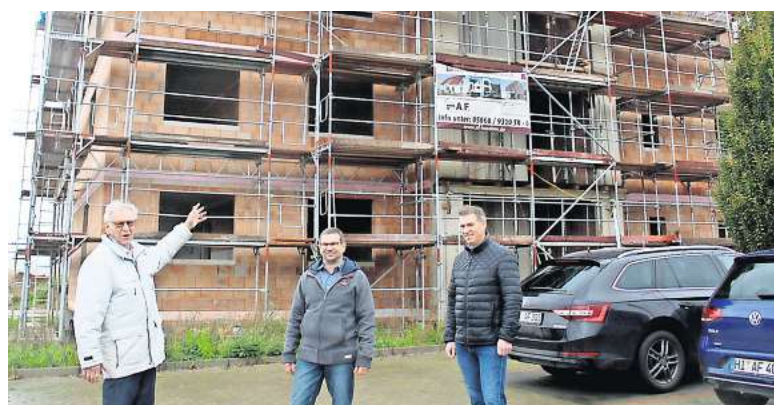
Albert Fischer (links), Sohn Peter (rechts) und Marc Booß von A.F. Hausbau stellen den Rohbau des neuen Bürogebäudes vor. FOTO: MELLANIE CAGLAR
