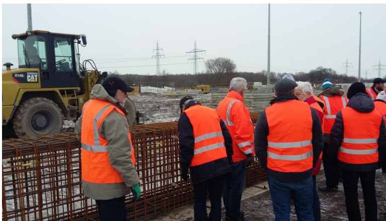
Bewehrungskorb Kranbahn Foto: Nadja Braun
