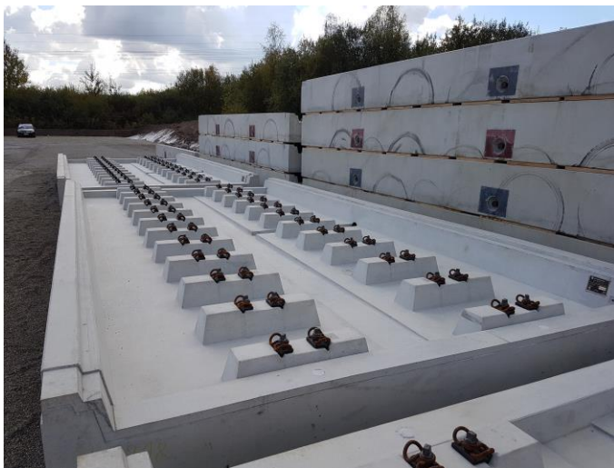
Zwischenlagerfläche Gleistragwannen Foto: Projekt
