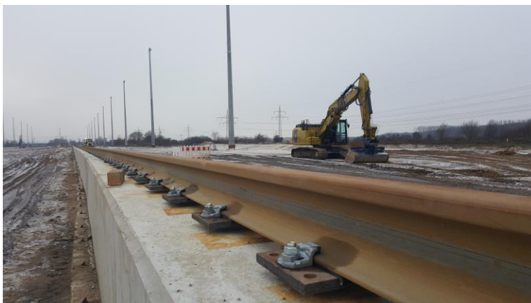
Nördliche Kranbahnschiene auf dem Kranbahnbalke im Bogen Foto: Nadja Braun
