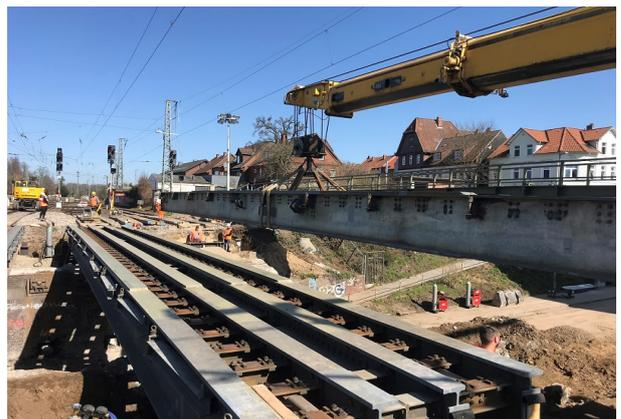
Einbau Gleishilfsbrücke mit EDK im Gleis 205
