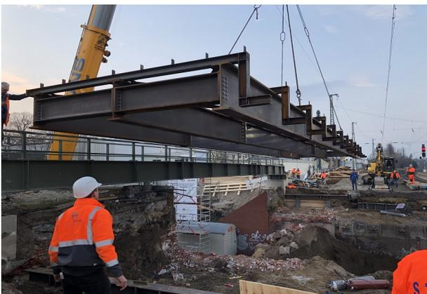
Einbau Bahnsteighilfsbrücke am Gleis 201
