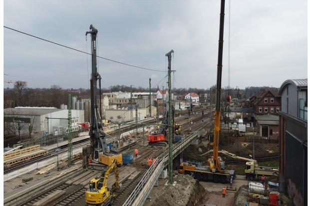
Herstellung der Gründungspfähle für die Gleishilfsbrücken Gleis 203-205
